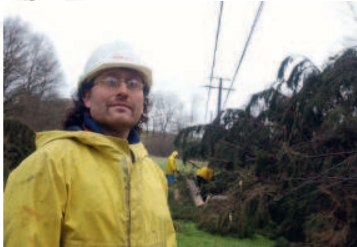
Aufräumarbeiten nach dem Orkan Kyrill
