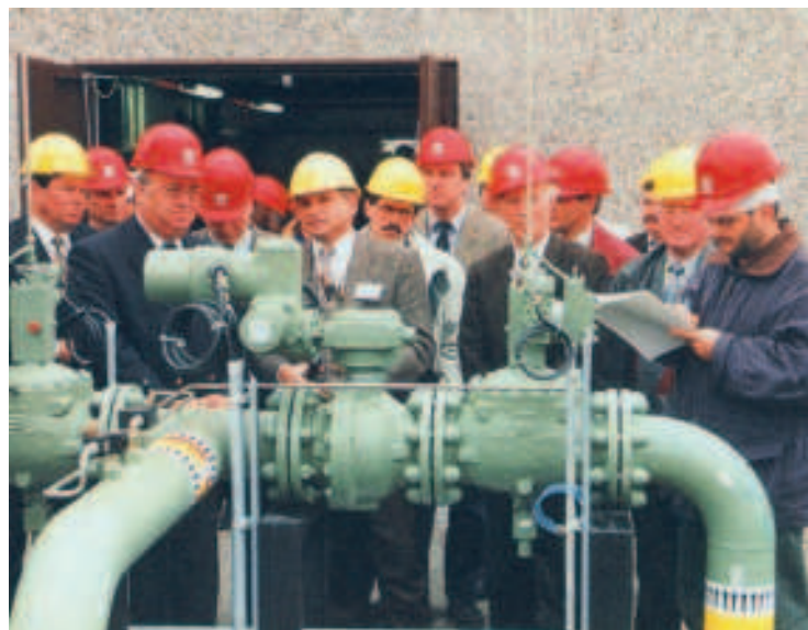
Inbetriebnahme des ersten Speicherhorizonts des Erdgasspeichers Allmenhausen am 17.10. 1996
