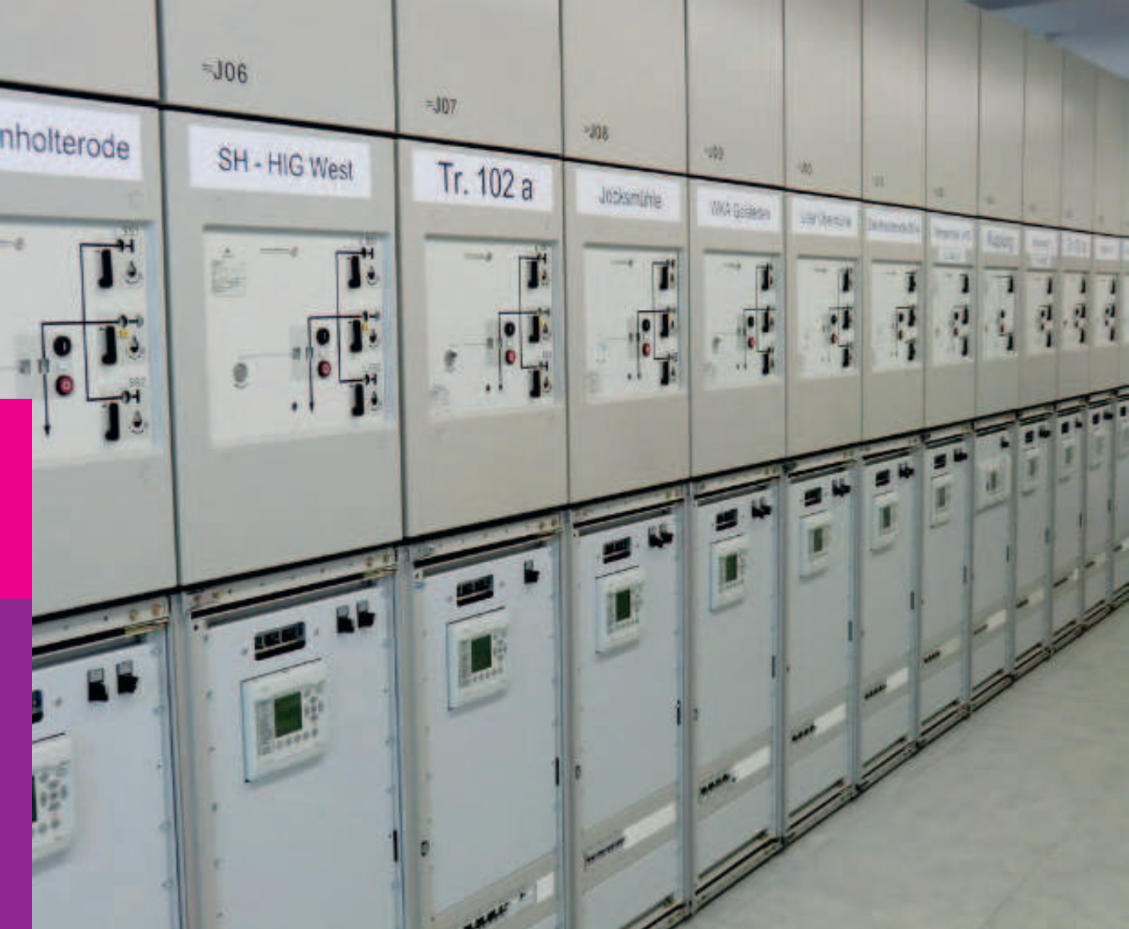
20-kV-Schaltanlage im Umspannwerk Heiligenstadt
