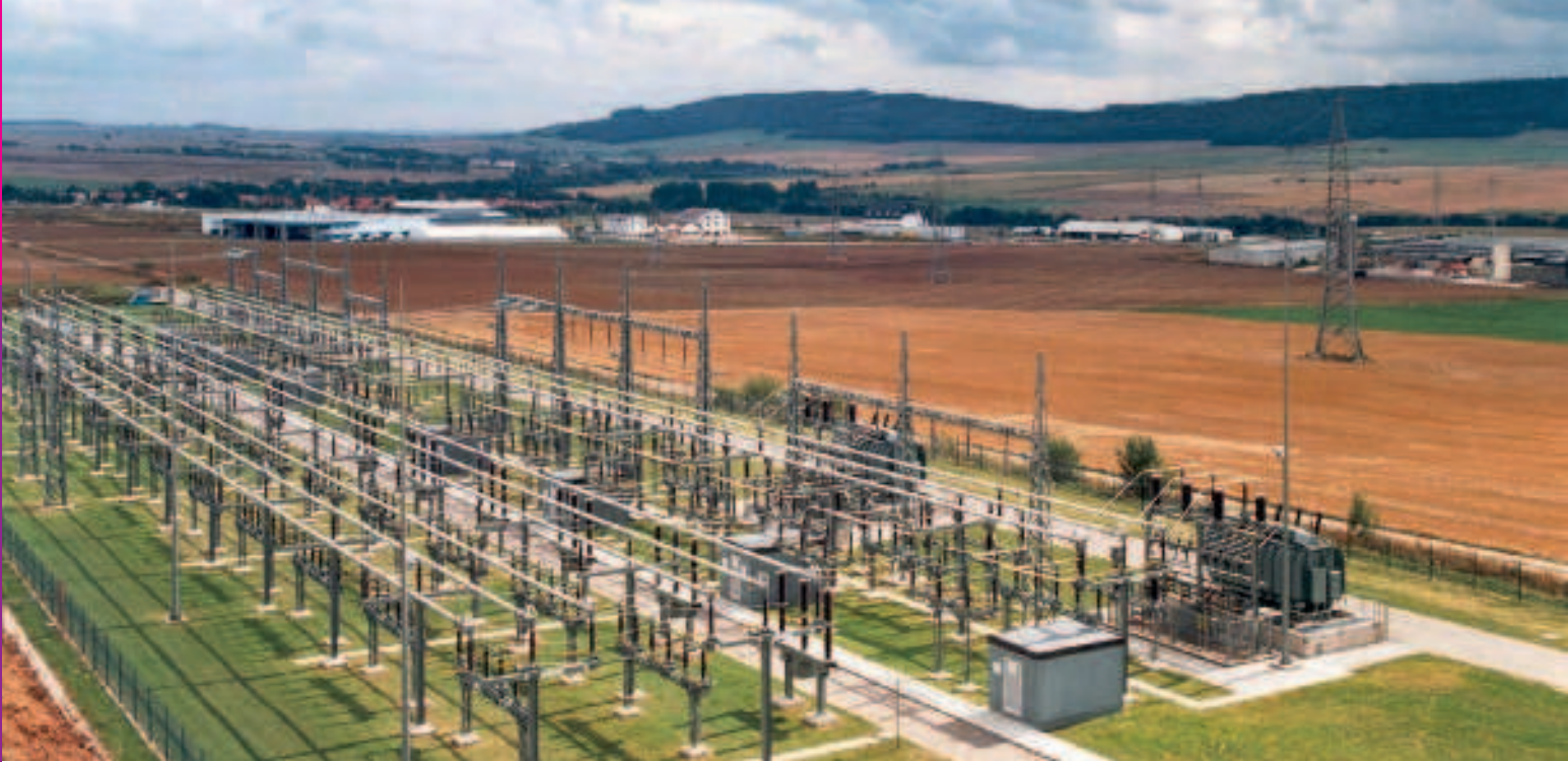
Das TEAG-Umspannwerk in Eisenach
