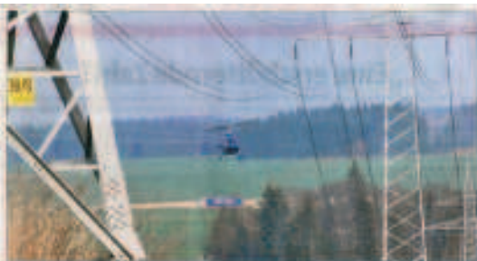
Hochspannungs-Freileitungen auf Schäden untersucht Ein- und Zweipolwerke werden, wenn Ersatz benötigt, durch die Mitarbeiter der E.ON Energy Research Center (ERC) überprüft. Die Mitarbeiter der ERC sind dabei dabei, die Freileitungen auf Schäden zu untersuchen. Die Mitarbeiter der ERC sind dabei dabei, die Freileitungen auf Schäden zu untersuchen.
