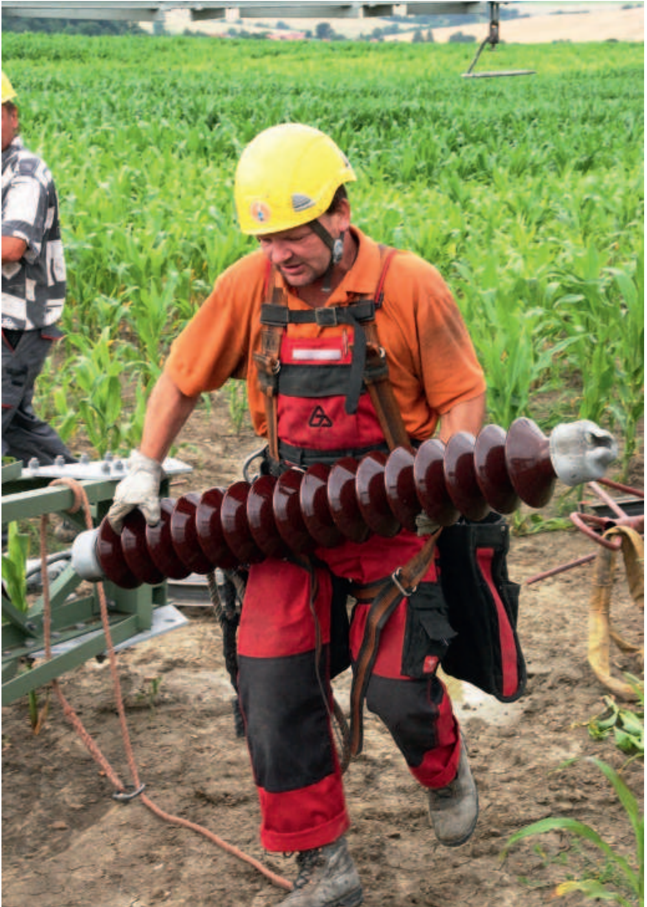
Arbeiten im 110-kV-Netz haben es in sich, hier bei Bürgel.
