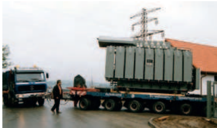
Trafotransport für das Umspannwerk Königsee
