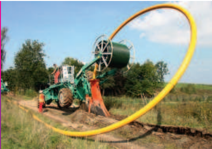
Ein Leitungspflug bei der Arbeit
