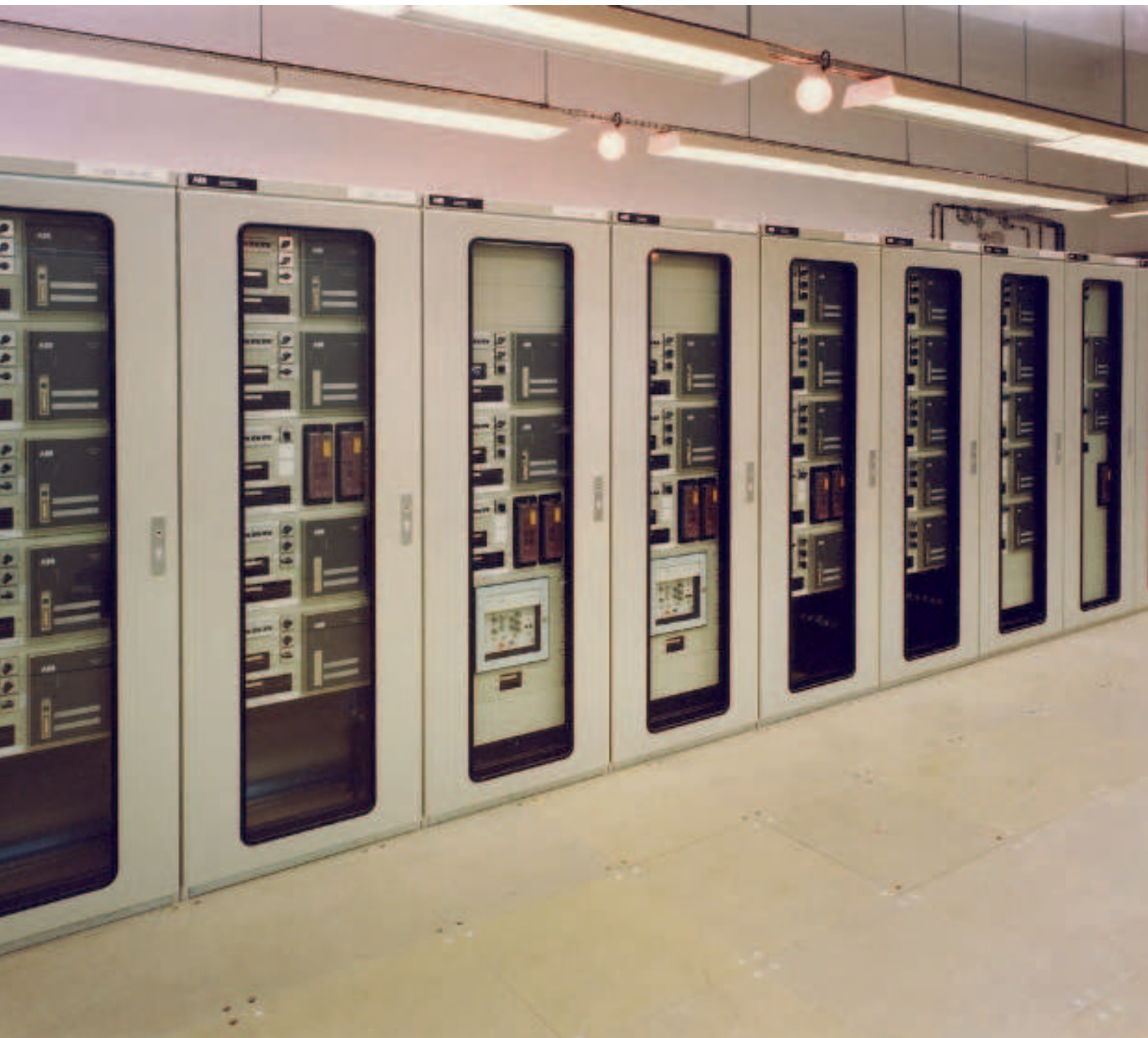
Schutzschränke im Umspannwerk Bleicherode
