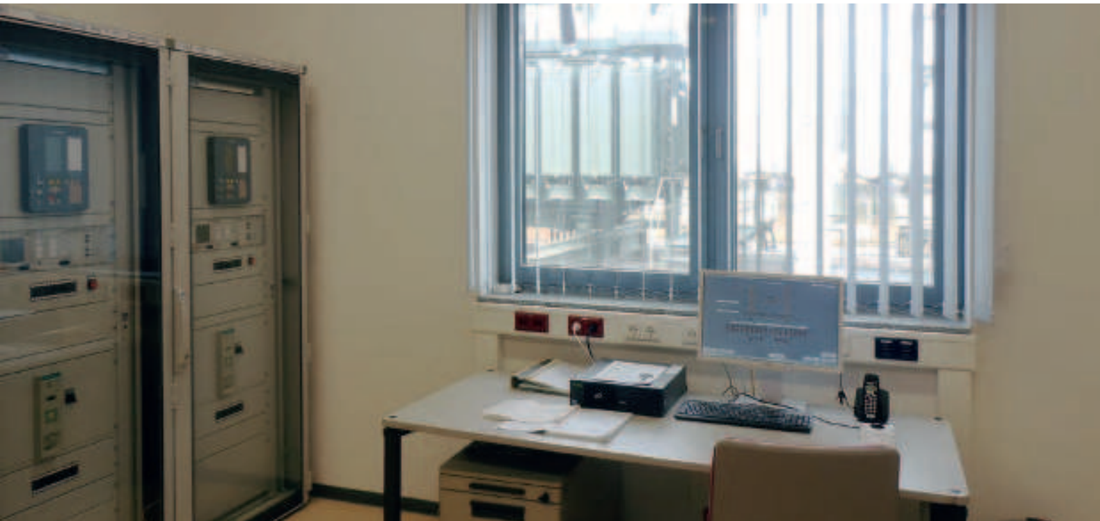
Bedien-Arbeitsplatz im Umspannwerk Ebeleben
