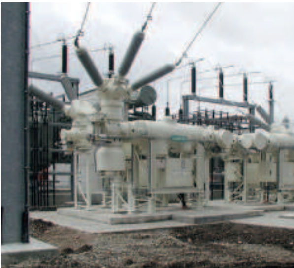
110-kV-HIS-Anlage im Umspannwerk Ilmenau
