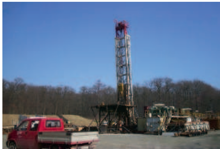
Vorbereitungen für die 330 Meter tiefen Vertikalbohrungen.
