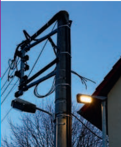
Heute bereits Geschichte: alte (l.) und neue LED-Straßenbeleuchtung noch nebeneinander
