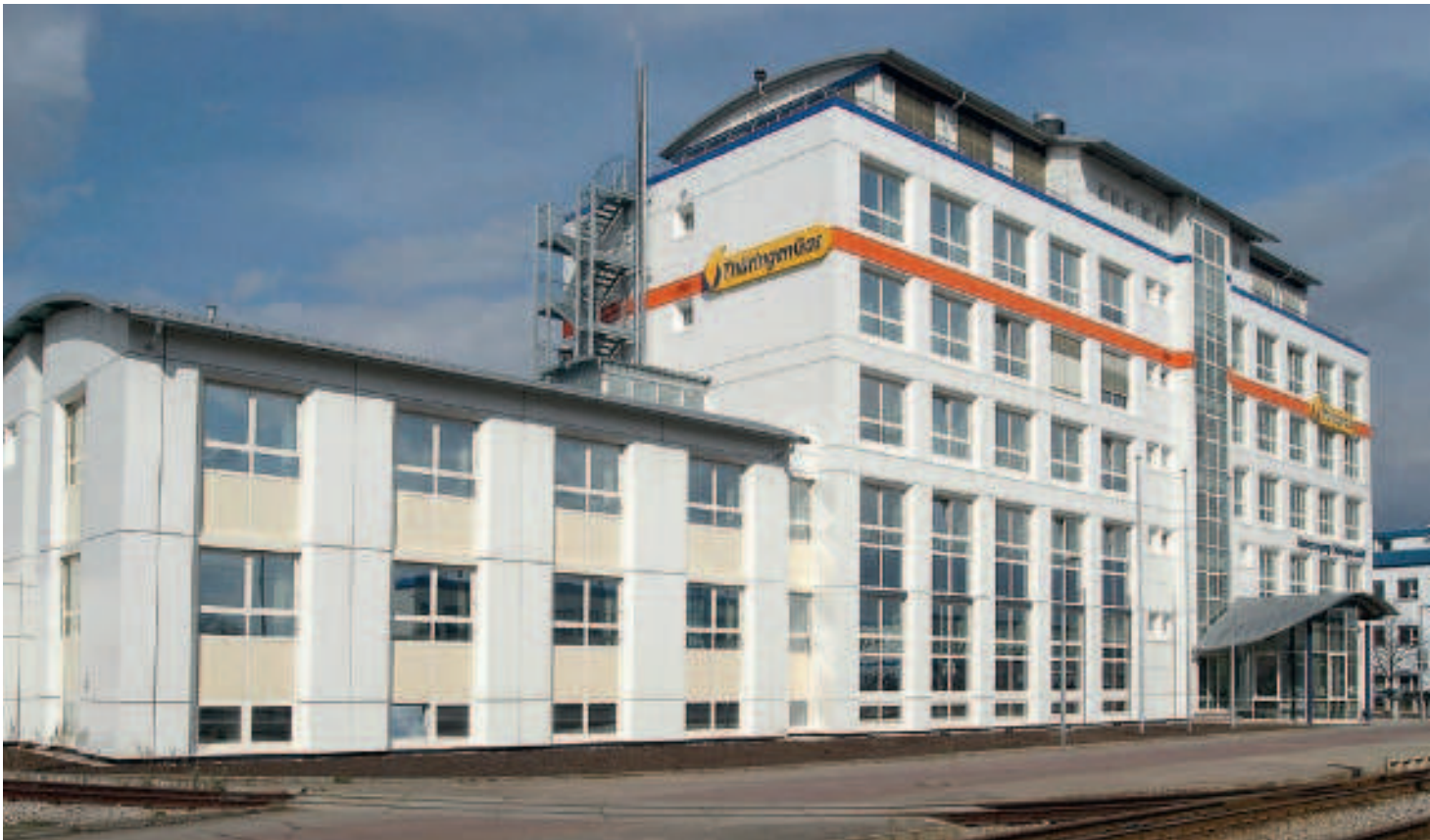
2003 wurde das neue Erfurter Verwaltungsgebäude der GVT in der Stotternheimer Straße 9a eingeweiht.
