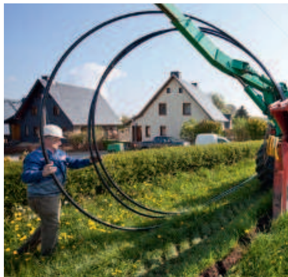
Verlegung neuer Leitungen als Voraussetzung für einen zuverlässigen Netzbetrieb
