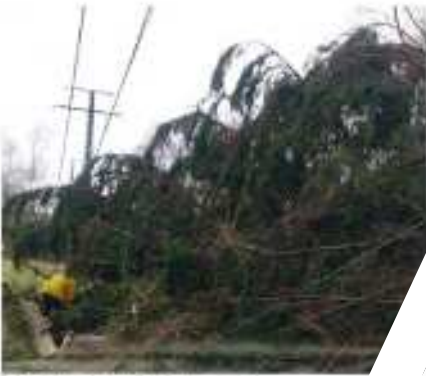
Ein Mitarbeiter führt einen Strommasten in der Nähe von einem Sturmgeschädigten Strommast.
