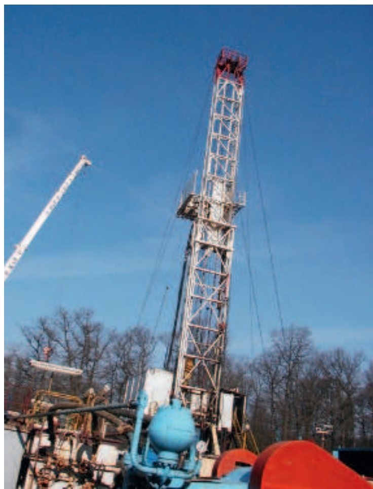
Aufbau für die anspruchsvollen Arbeiten im Untergrund
