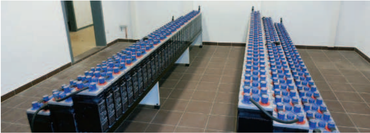
Batterieanlage im Umspannwerk Nordhausen
