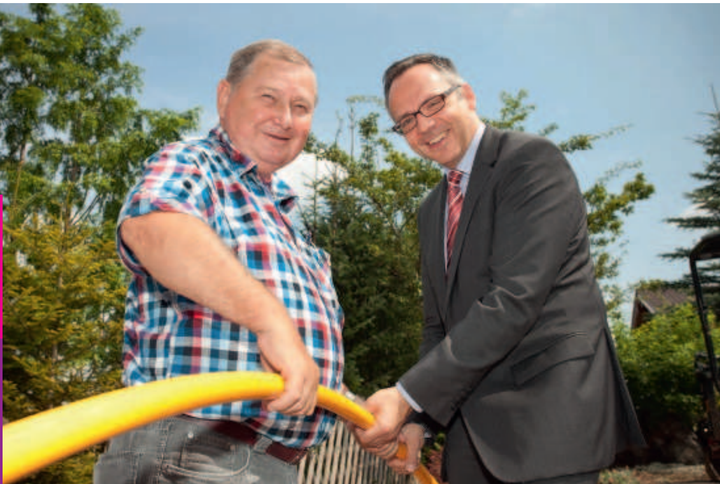
Baustart zur Erdgasnetzverdichtung in Wernrode am 6. August 2014
