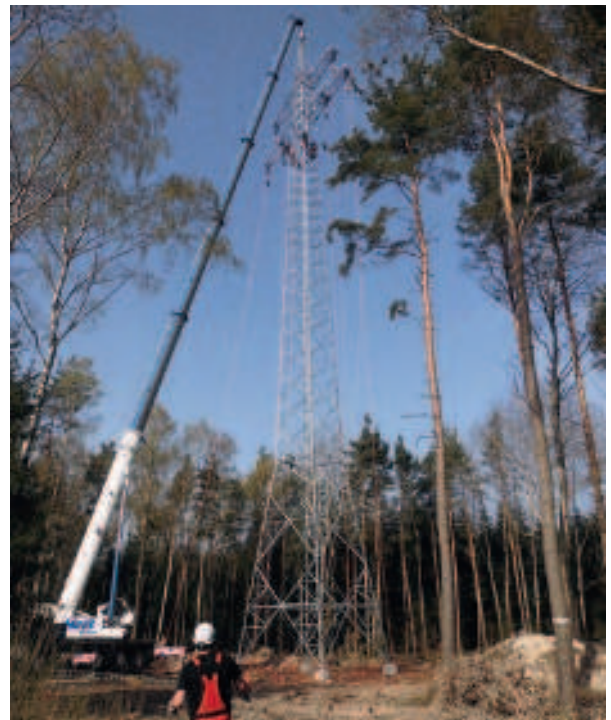
Mast für Waldüberspannung der 110-kV-Leitung Herda-Martinroda
