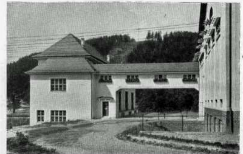
50/15 kV Umspannwerk Sonneberg, 5.450 kVA 1925
