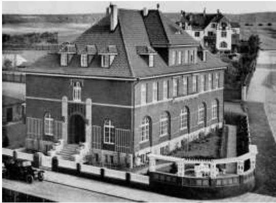
ÜZ Bleicherode Schillerstr.
