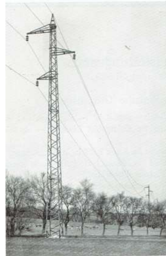
Abb. 17. 50 kV Doppelleitungsmast, vorerst ein Stromkreis ausgebaut.
