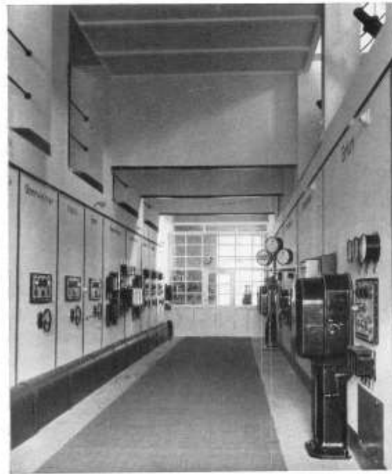
Abb. 42. Bedienungsgang des Umspannwerkes Weimar. Kraftspeicherantrieb für die 50 kV Freileitungen, für die übrigen Öl-schalter Handantrieb.
