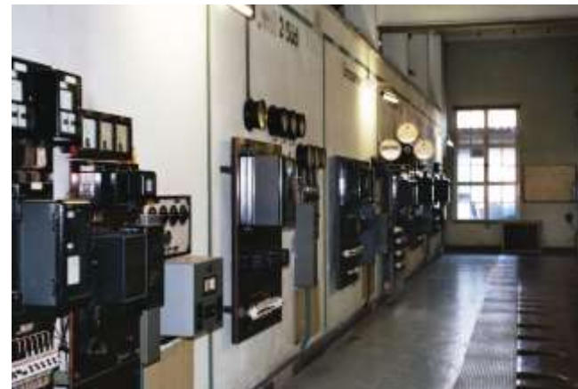
Abb. 49. 50 kV Ölschalterraum im Umspannwerk Weimar. Unterteilung durch Schottentür, Warnlampen auf den Zellenwänden.
