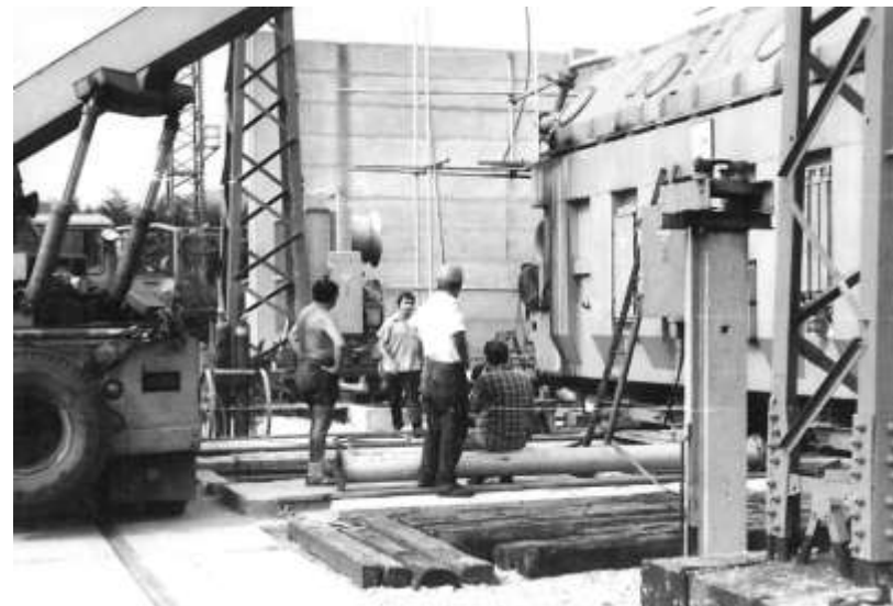
Aufstellung 220-kV-Trafo, UW Suhl
