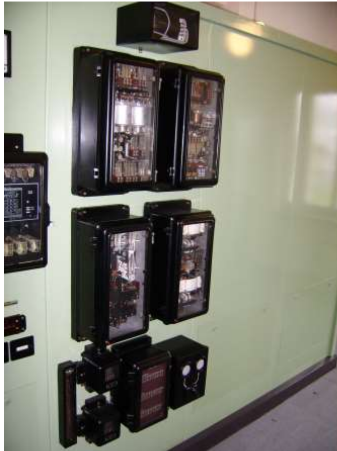
UW Neuhaus, Leitungsschutz. Siemens
