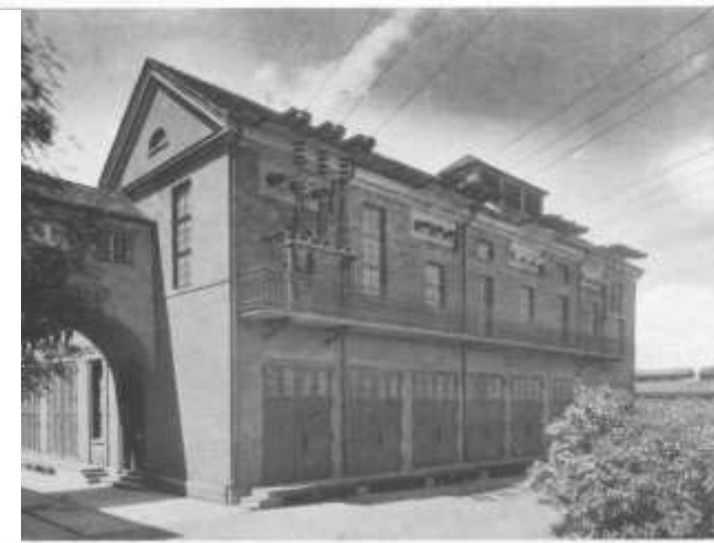
50/3 kV Umspannwerk Erfurt Durchgangsleistung 12.000 kVA 1924
