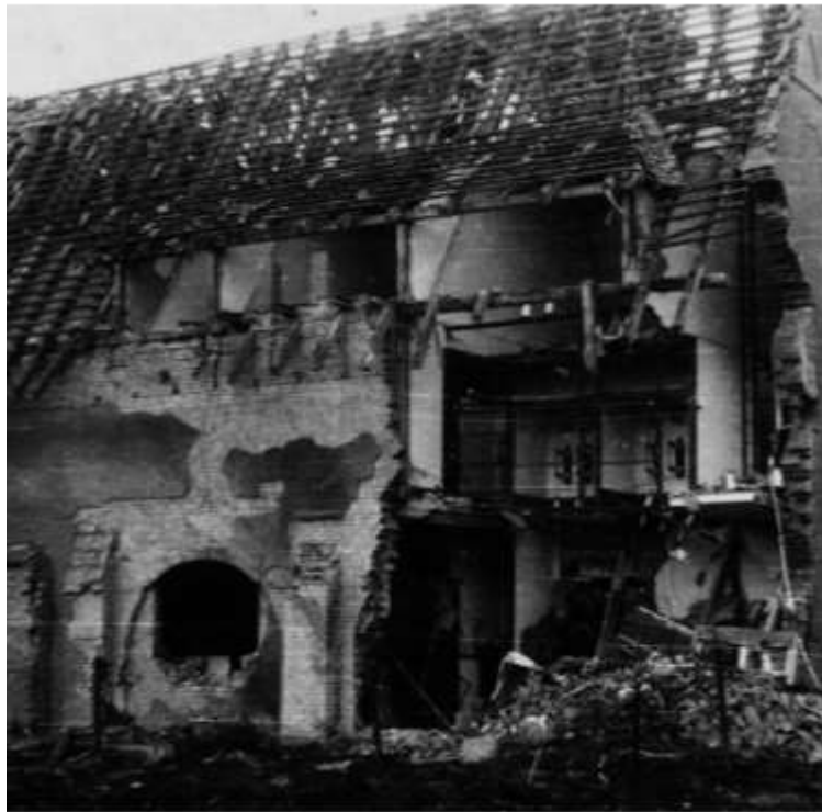
lomben heimgesucht – Umspannwerk Süd, 6. Februar 1945
