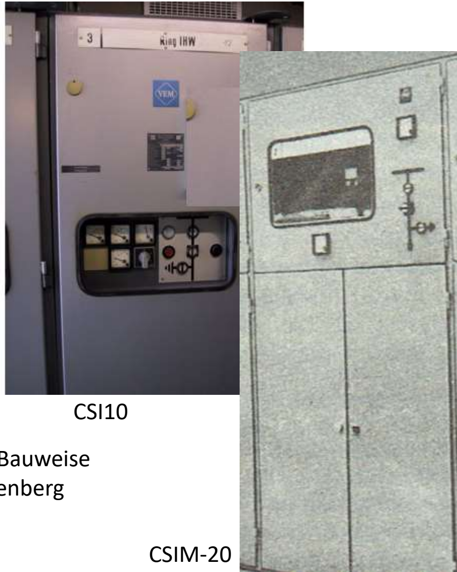
luftisolierte Schaltanlagen
