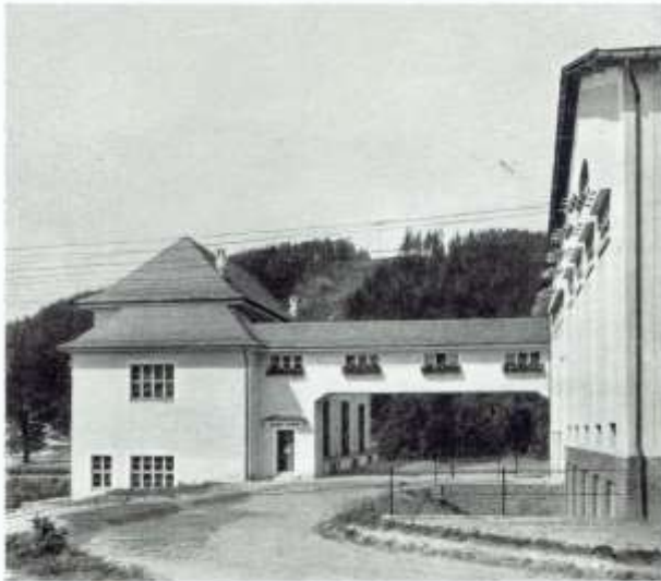
Abb. 37. Umspannwerk Sonneberg mit Verbindungsgang zu den Anlagen der Licht- und Kraftwerke Südthüringen G. m. b. H.
