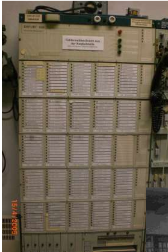
1982 Inbetriebnahme des Fernwirkgerätes „Erfurt 100“ im UW Gotha und Waltershausen
