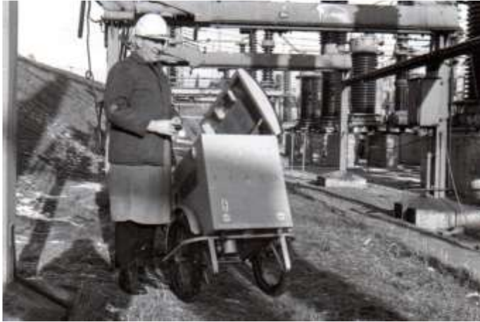
Einsatz Fehlerortungsgerät im UW Remptendorf
