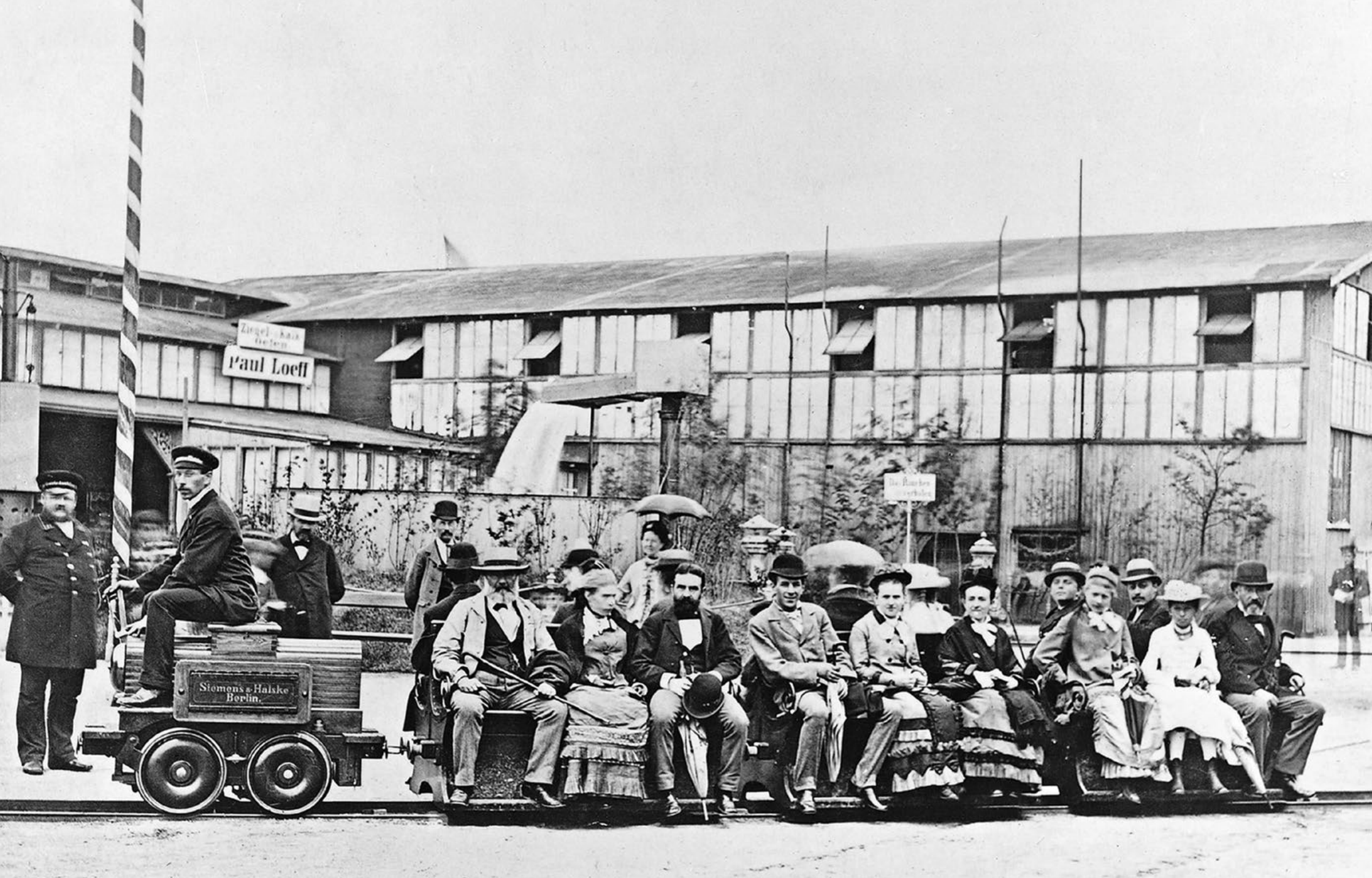
Erste elektrische Bahn der Welt, vorgeführt von Siemens und Halske auf der Berliner Gewerbeausstellung 1879
