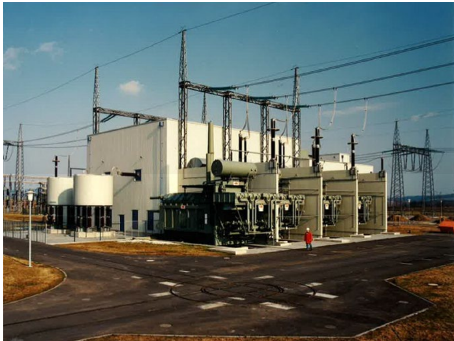
Bild 4: Gleichstrom-Kurzkupplung Etzenricht
