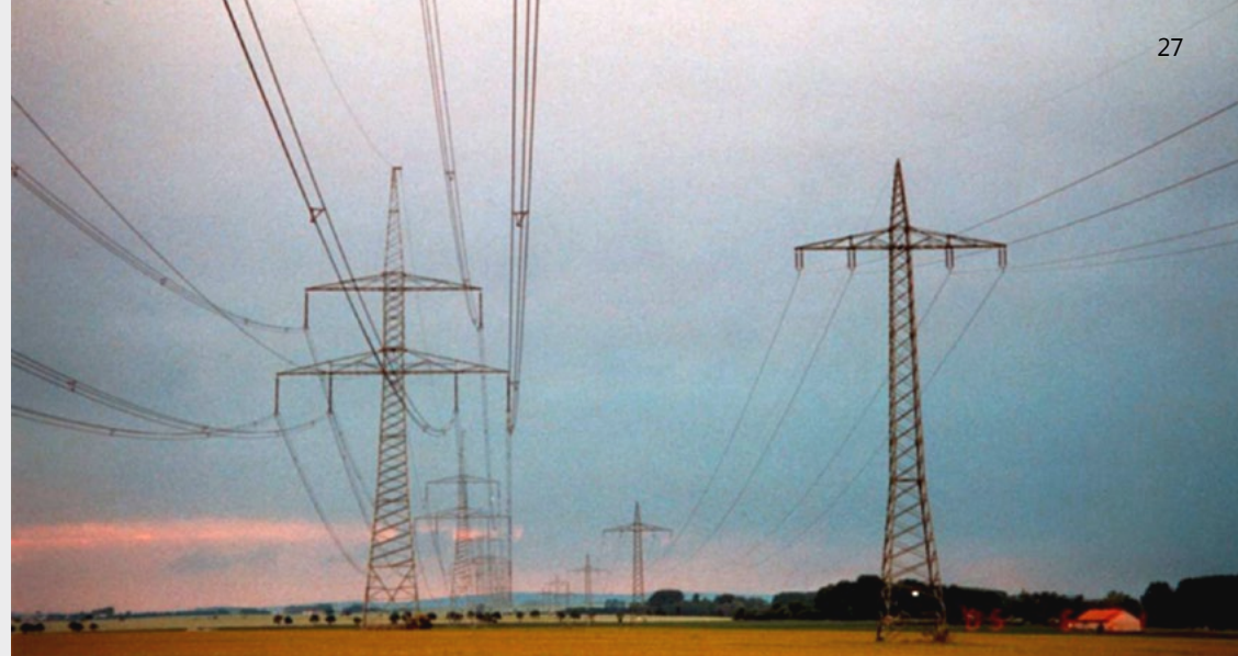
Bild 12: Leitungen der Wiedervereinigung, Nähe Gotha, 380 kV, 50 Hz und 110 kV, 16 ⅔ Hz
