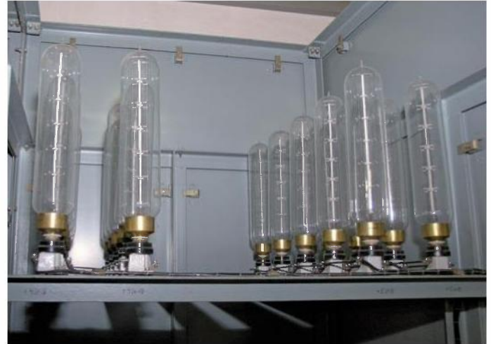
Bild 9: Fe-H-Widerstände, Bütow-Schutz
